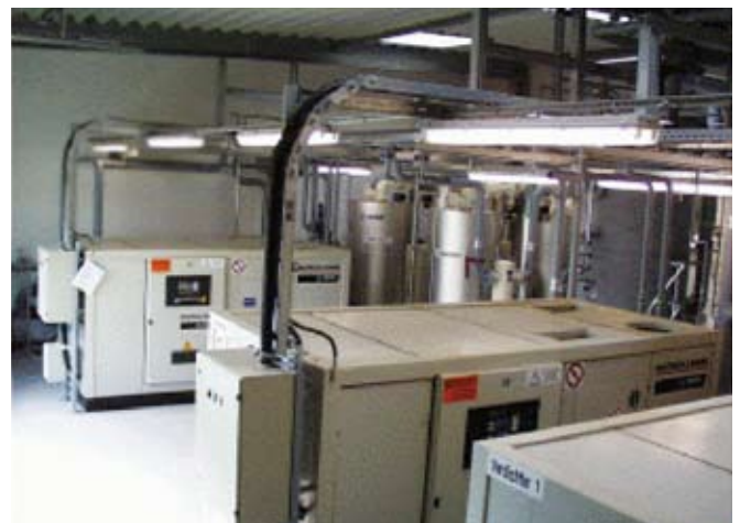
Druckluftherzeugung Bitterfeld
