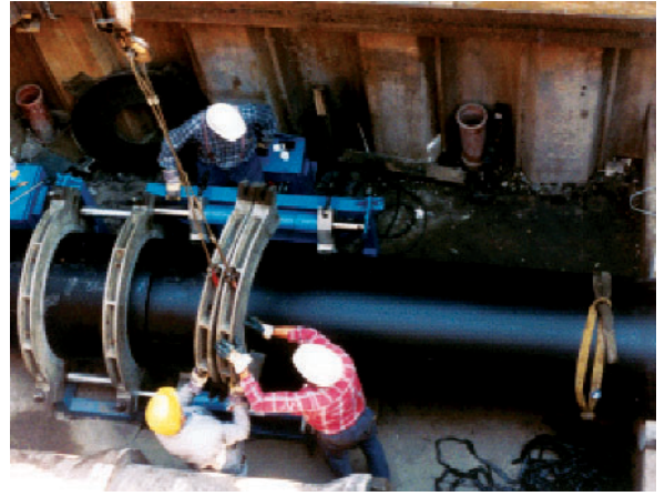
HDPE-Rohrverbindung DN 1000
