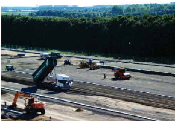
Flächenbefestigung für ein Logistikzentrum
