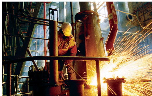
Demontage von Reaktionskesseln in einem chemischen Betrieb
