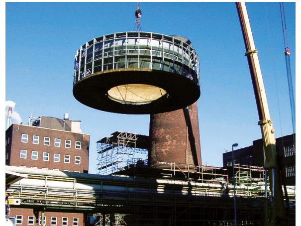
Demontage eines Wasserturms im Chemiapark Leverkusen
