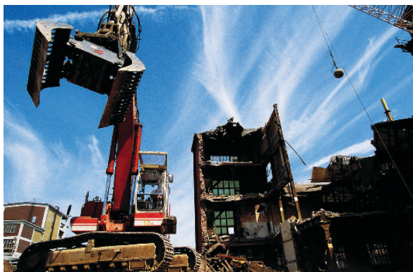
Abbruch von Produktionsgebäuden
