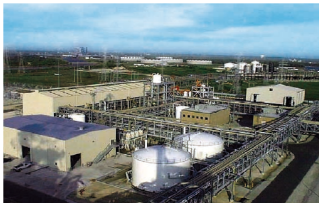
Установка электролиза хлора, Бейтаун (США)
