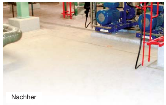
Nach Abbruch von einigen Tausend Quadratmetern defektem Kellerfußboden (oben) unter laufendem Betrieb ist hier jetzt wieder alles dicht (unten).
