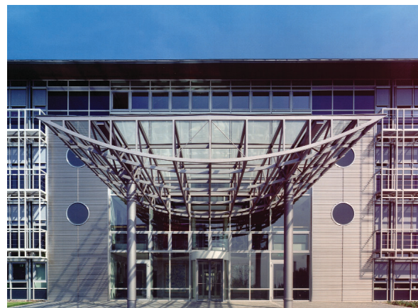
Bürogebäude in Wuppertal
