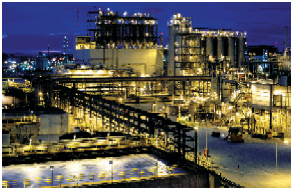
Produktionsanlage in Thailand
