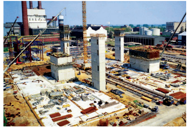
Errichtung eines Produktionskomplexes in Dormagen
